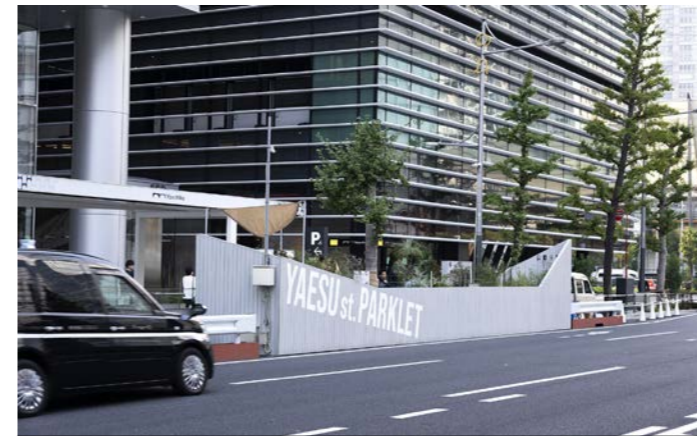
【パークレット全景（車道側）】
